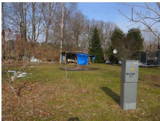
zemes gabals ar elektrības pieslēgumu
